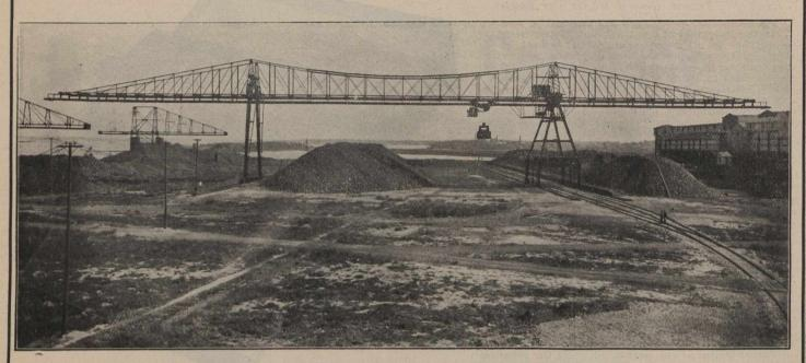
ASTORIA LIGHT, HEAT & POWER CO., ASTORIA, N.Y., SHOWING BRIDGE TRAMWAY.
