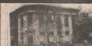
▲ CARRALL & HASTINGS 商業樓宇, 四租客, 三層及另一樓宇, 月入 $3400, 開價 $650,000 梁寶琴 688-7888 潘錦明 645-9293
