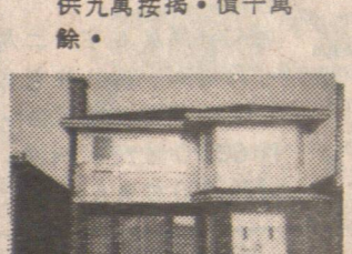
△想換新屋, 近域多利及51街正在建造中
