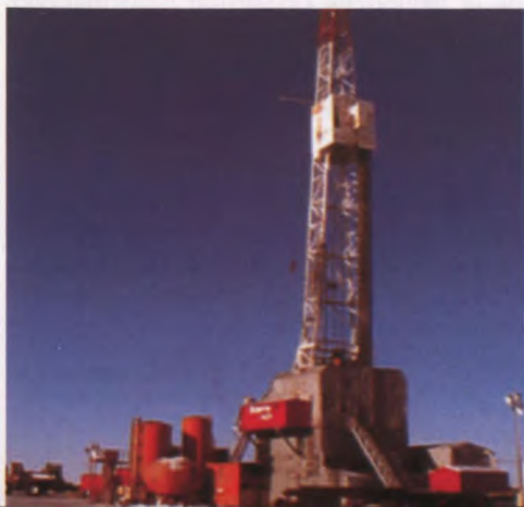
◀ Drilling equipment for the MALLIK 2L project ◀ Équipement de forage du projet MALLIK 2L
