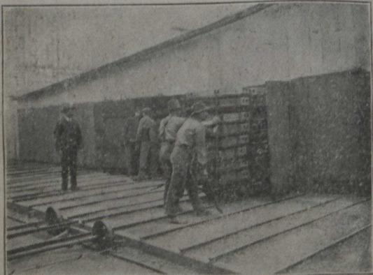
Le séchage des briques au moyen d'un éventail mécanique. La température est de 60° à une des extrémités du séchoir et de 120° F. à l'autre extrémité.
