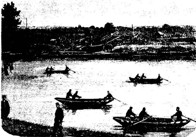
TRAVAUX DE DEFENSE EXECUTES SUR LA MORAVA.
