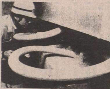
日本一名工程師正檢查建築物的減震器。減震器是由鋼條和其他材料製成，裝置在建築物的底部。
