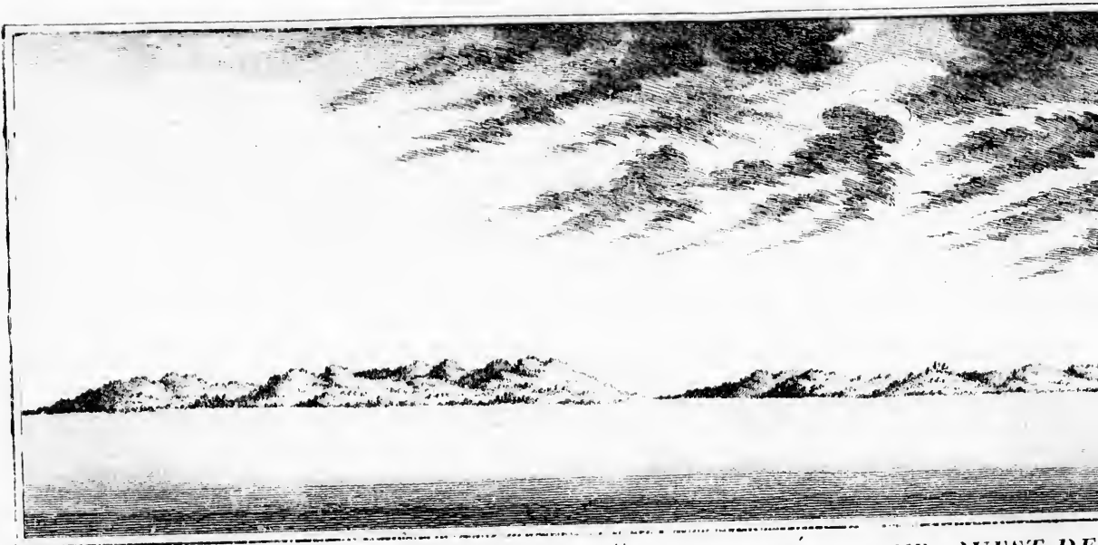
VUE DU COSTÉ DU SUD OUEST DE
