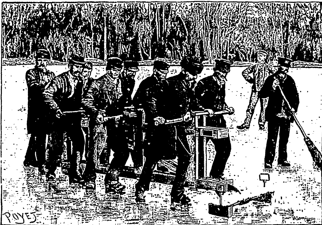
Machine à raboter la glace pour aplanir sa surface, employée sur les lacs gelés du Bois de Boulogne, à Paris.
