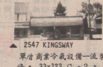
▲2547 KINGSWAY 單層商業冷氣設備一流裝 修，33x123 C-2， $288,000
