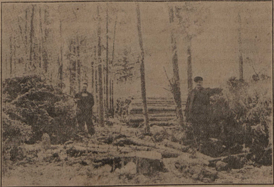
Piles de branchages pour le brûlage.
