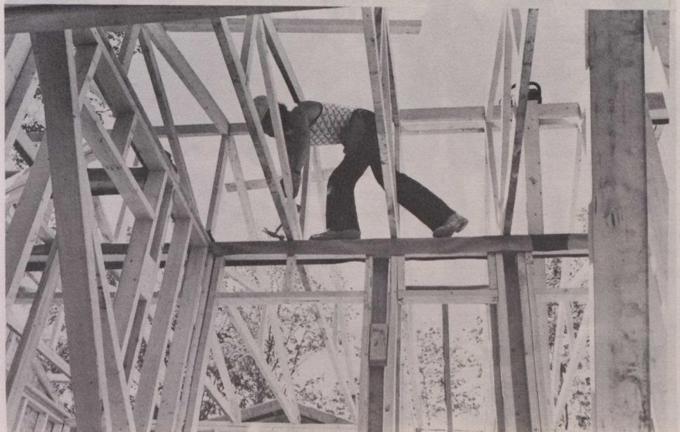
*Les matériaux de charpente en bois préfabriqués sont assemblés sur place.*
