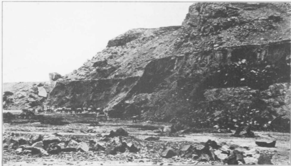
Carrière—type de pierre à sable bitumineuse, exploitée par la City Street Improvement Co., près de Santa Cruz, Cal., E.U.A. Epaisseur moyenne de la roche bitumineuse, environ 60 pieds. Manteau stérile consiste d'argiles Monterey, dures, et de 40-60 pieds d'épaisseur.
