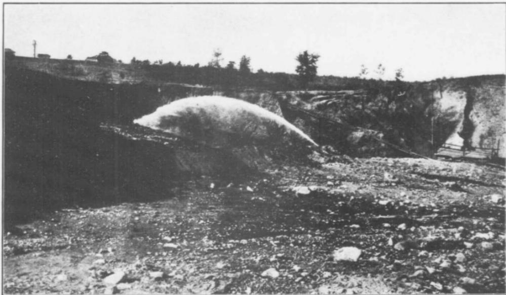
Mine Rowe, Minnesota. Vue générale, montrant l'enlèvement hydraulique du manteau stérile, tuyau d'alimentation d'eau, tuyau de décharge, et canon hydraulique.
