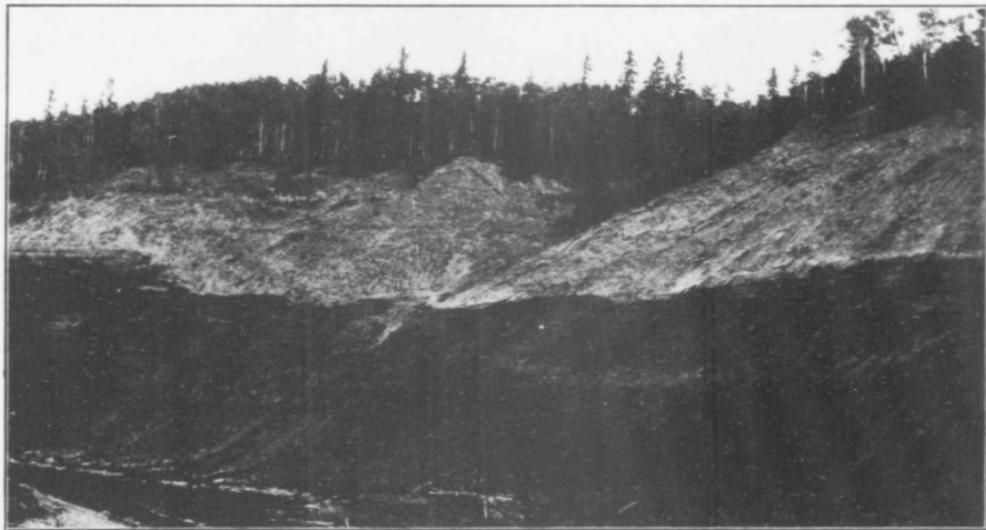
Affleurement type de sable bitumineux sur la rive nord de Horse Creek,  $\frac{1}{4}$  de mille de sa source. Epaisseur approximative du sable bitumineux, 90 pieds, épaisseur du manteau stérile, à 400 pieds du bord du creek, 120 pieds.
