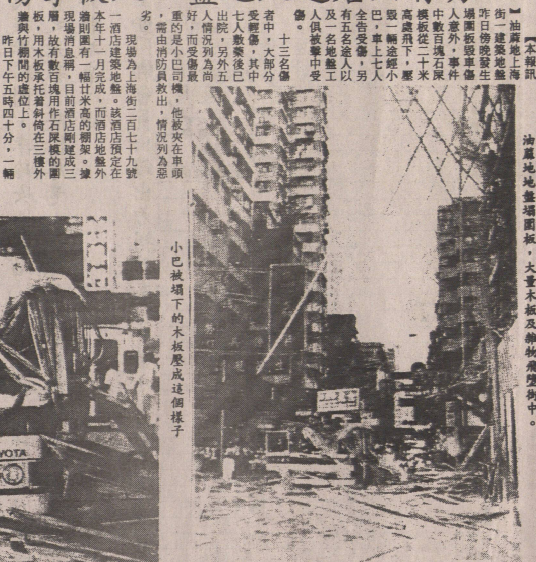
小巴被塌下的木板壓成這個樣子
