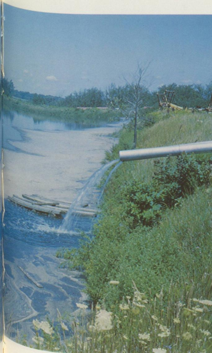
Bassin artificiel du type habituellement utilisé pour traiter les effluents des usines de produits alimentaires.
