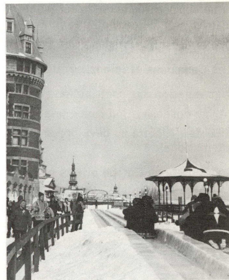
La glissade près du Château Frontenac est l'une des attractions d'hiver de la vieille Capitale. On y descend sur une distance de 300 pieds à plus de 60 milles à l'heure.
