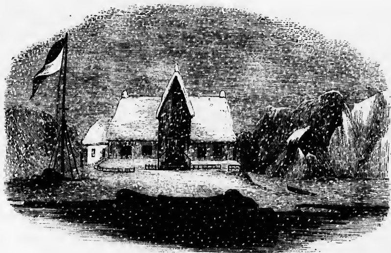
Niederlassung Livels auf der Insel Disco. (Inspector-Haus.)
