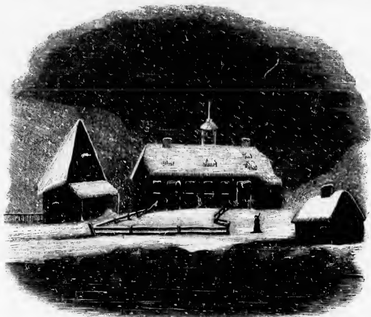
Herrnbuter Außendeckung Lichtenfels.
