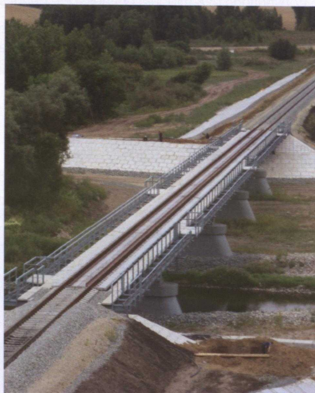
Le viaduc ferroviaire de la rivière Miass a été complété en septembre 2007.
