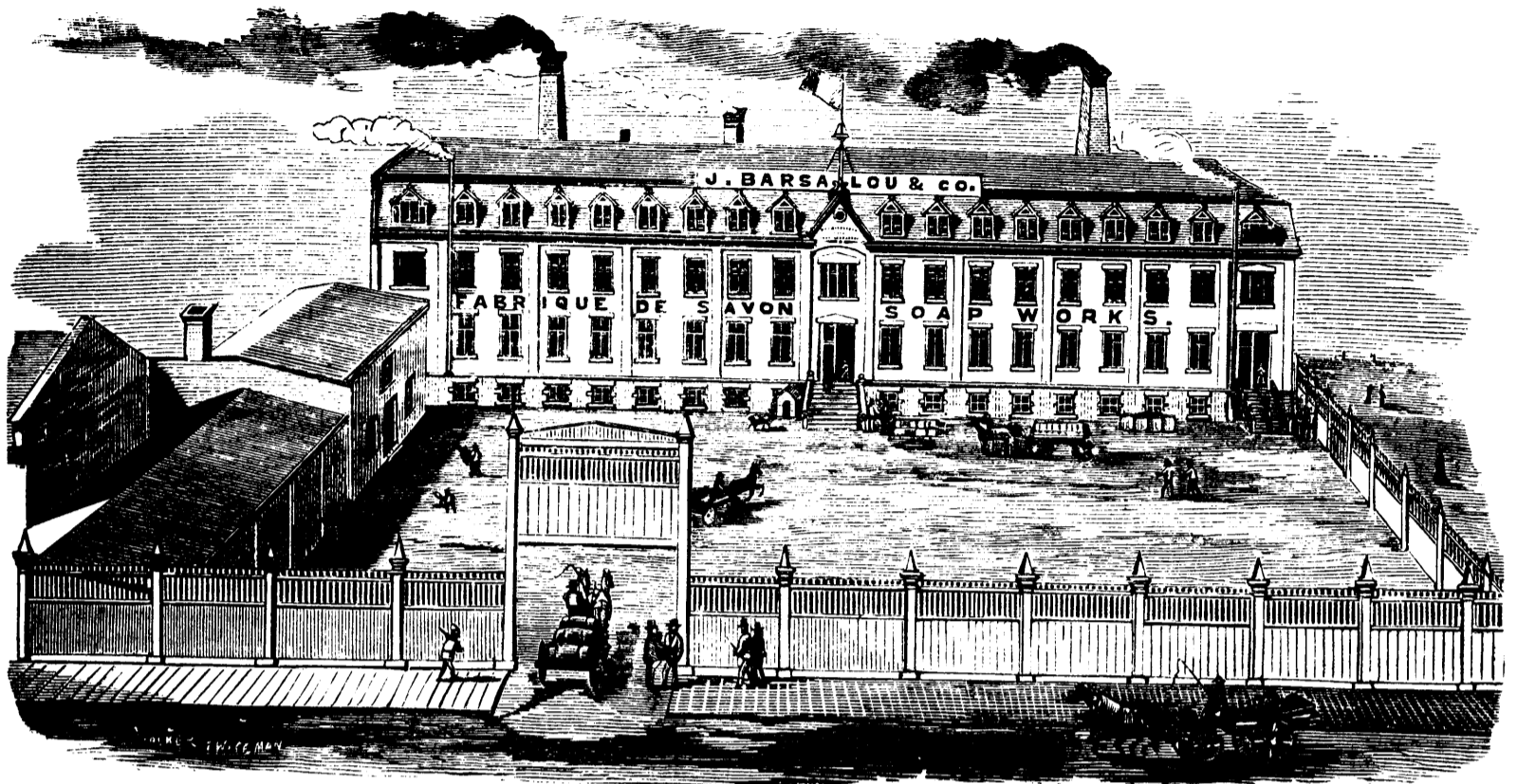
NOUVELLE USINE POUR LA FABRICATION DU SAVON ; MM. J. BARSALOU & CIE., PROPRIÉTAIRES ; COIN DES RUES DURHAM ET STE. CATHERINE, MONTRÉAL
