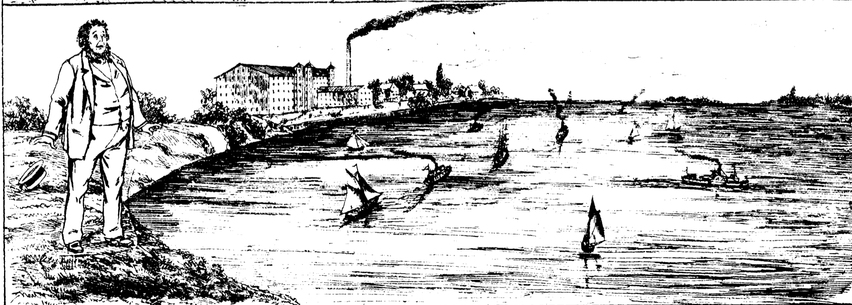
LE TUNNEL ENTRE LONGUEUIL ET HOCHELAGA LE RÊVE ET LA RÉALITÉ
