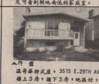
▲ 3515 E. 29TH AVE. 樓上 3 房, 樓下 3 房, 地區好, 開 價 $209,000。$199,900
