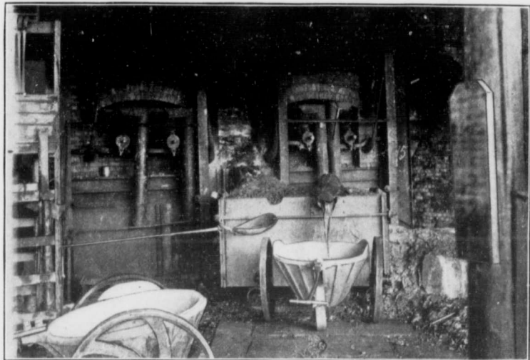
Fourneaux à chemises d'eau, à Evje, Norvège.
