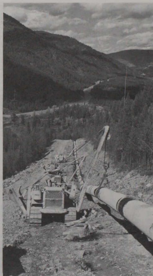
▲石油輸送管の敷設
