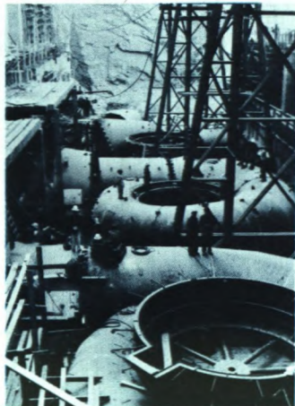
Centrale en cours de construction à l'aménagement de Warsak (Pakistan).
