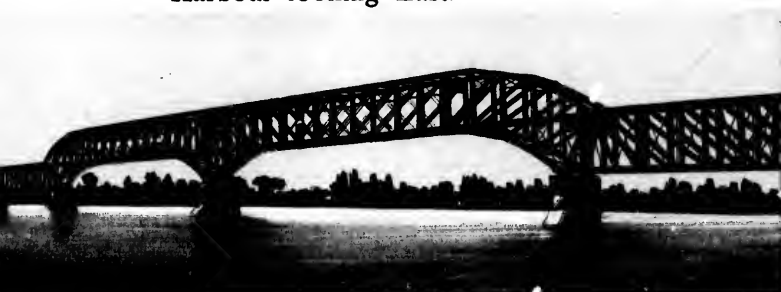
C. P. R. R. Bridge.
