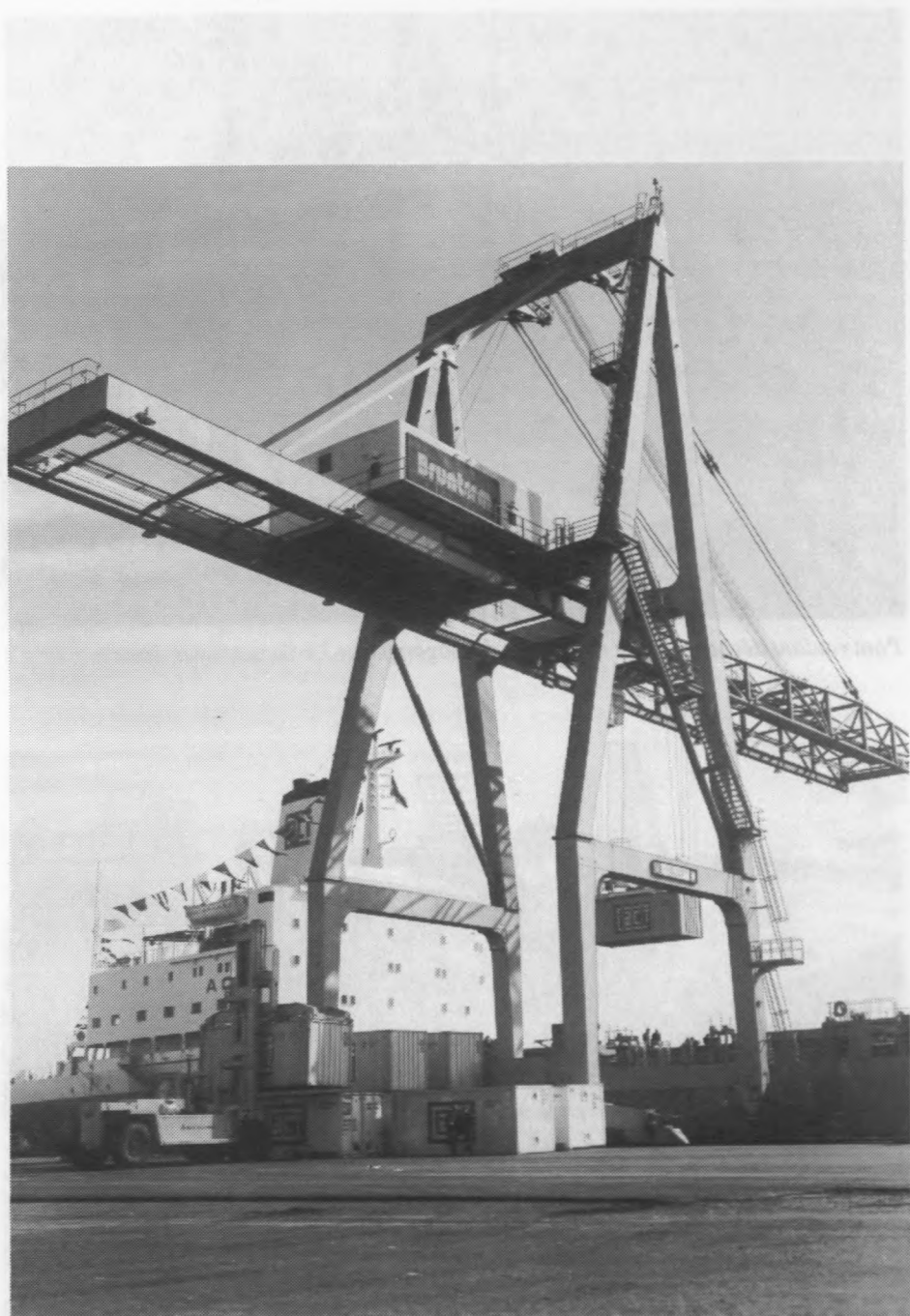
Grue de quai de type courant.
