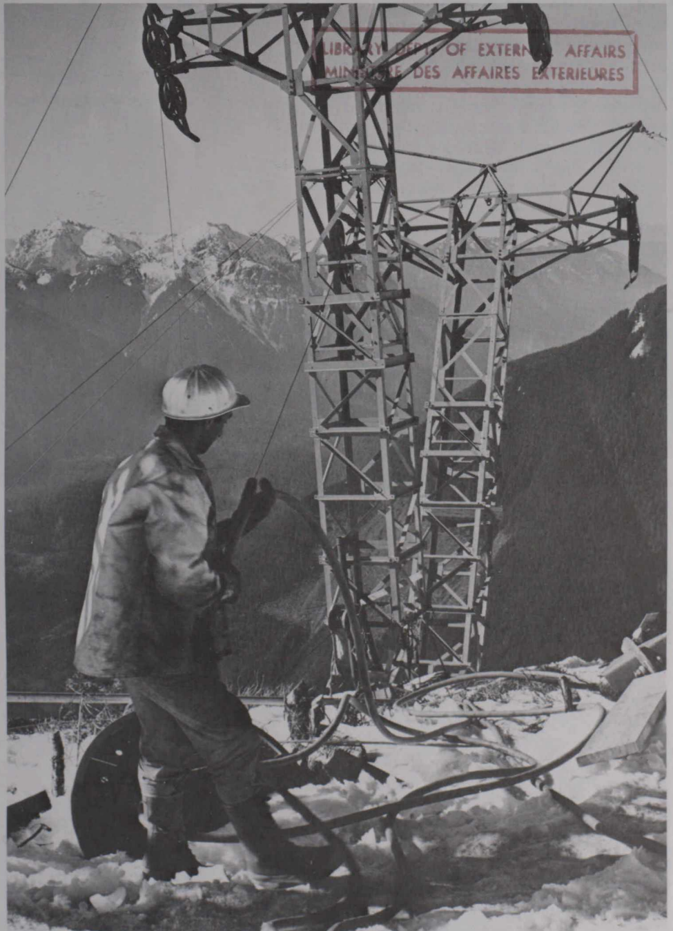
Het spannen van leidingen voor microgolven in Coquihalla Valley, Brits-Columbia.
