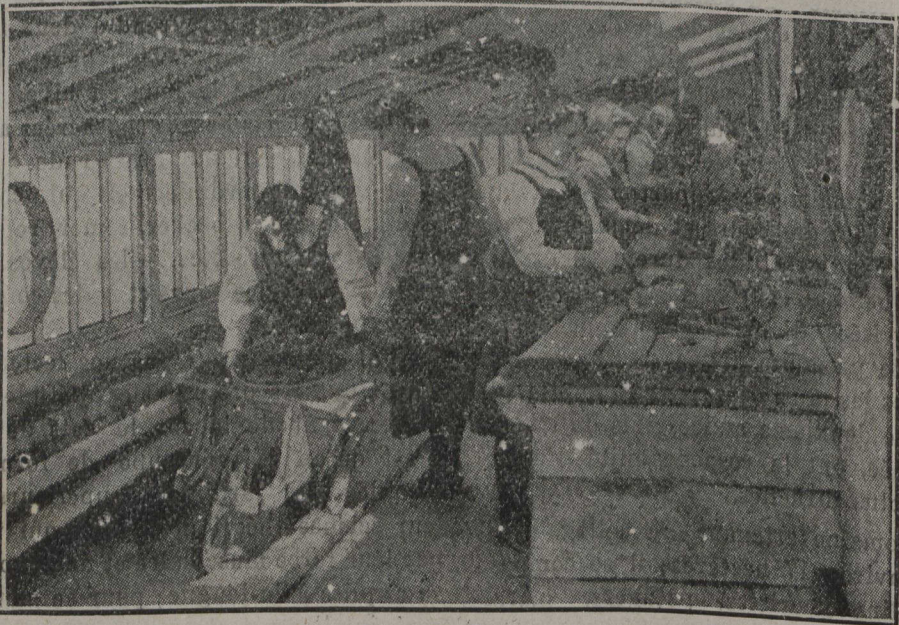
Les travaux dans la serre.
