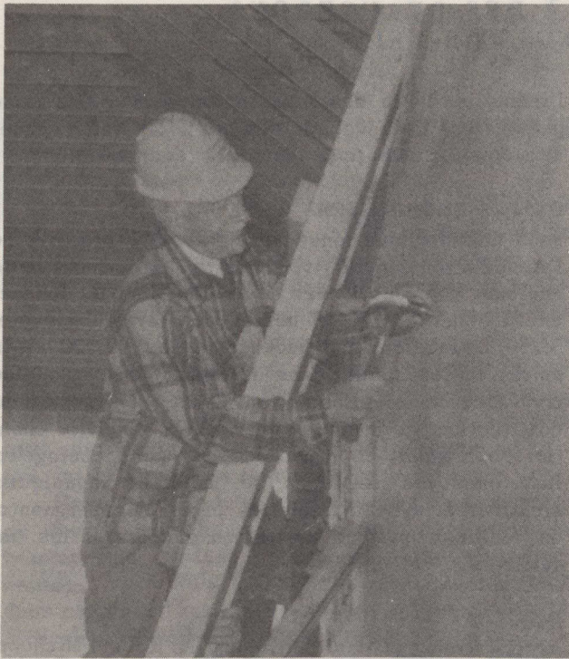
Le gouverneur général, M. Roland Michener s'est rendu sur le chantier de reconstruction pour encourager les travailleurs bénévoles. Muni du chapeau des ouvriers, il n'a pas hésité à monter dans une échelle, marteau main, pour aller fixer un panneau au mur de l'usine.
