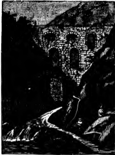
FIG. 168.—Aqueduct on the Rodadero.
