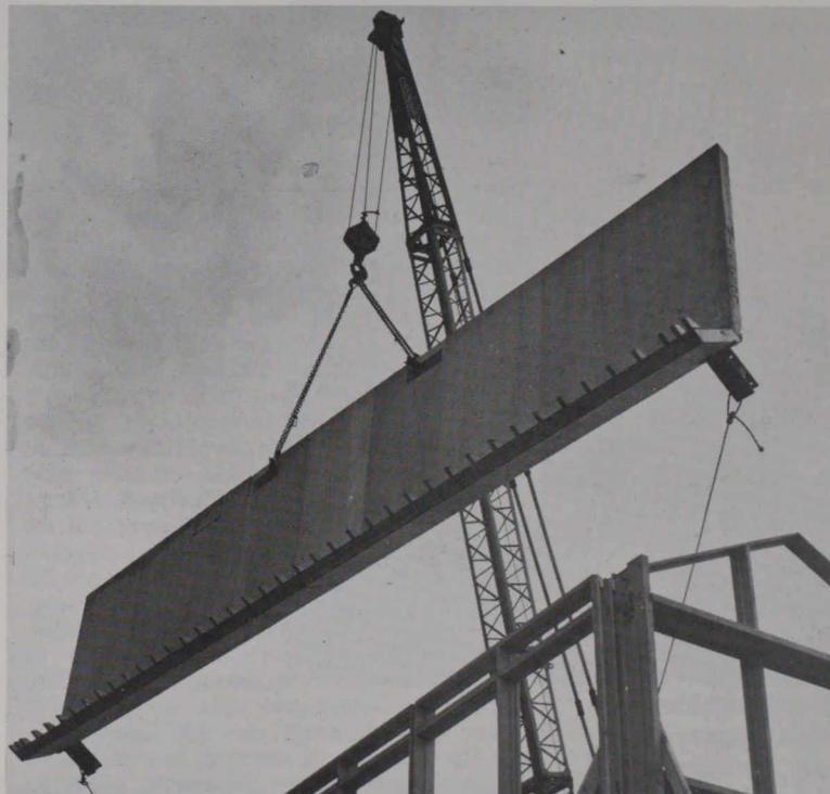
*Un élément de toiture autoportante en voiles polygonaux de contreplaqué*
