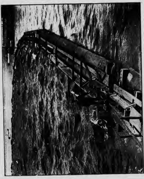
ART OF DISCHARGE PIPE, HYDRAULIC DREING NO. 7, SHOWING BALL-AND-SOWEET SPRING JOINT BETWEEN RAT OF 100 FERT.
