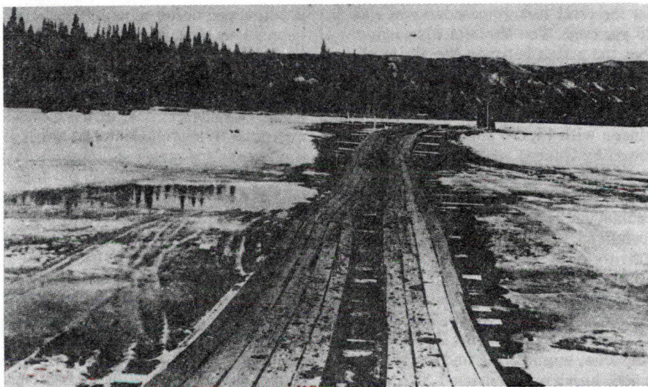
Construcción de la Carretera Alaska sobre el río Peace, Colombia Británica, 1942.
