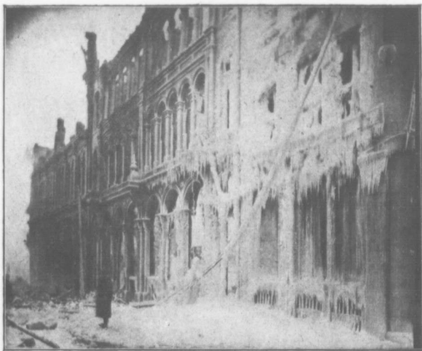
Vue de la façade de l'Entrepôt, après l'incendie chez James Coristine & Co., Limited Montréal.
