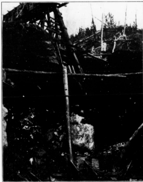
Elevator Pit, Omineca.
