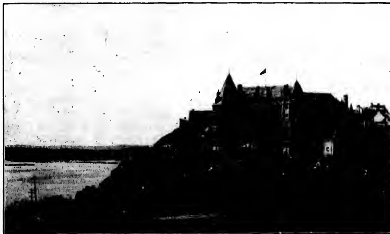
Le château Frontenac, bâti sur le site du château Saint-Louis, à Québec.
