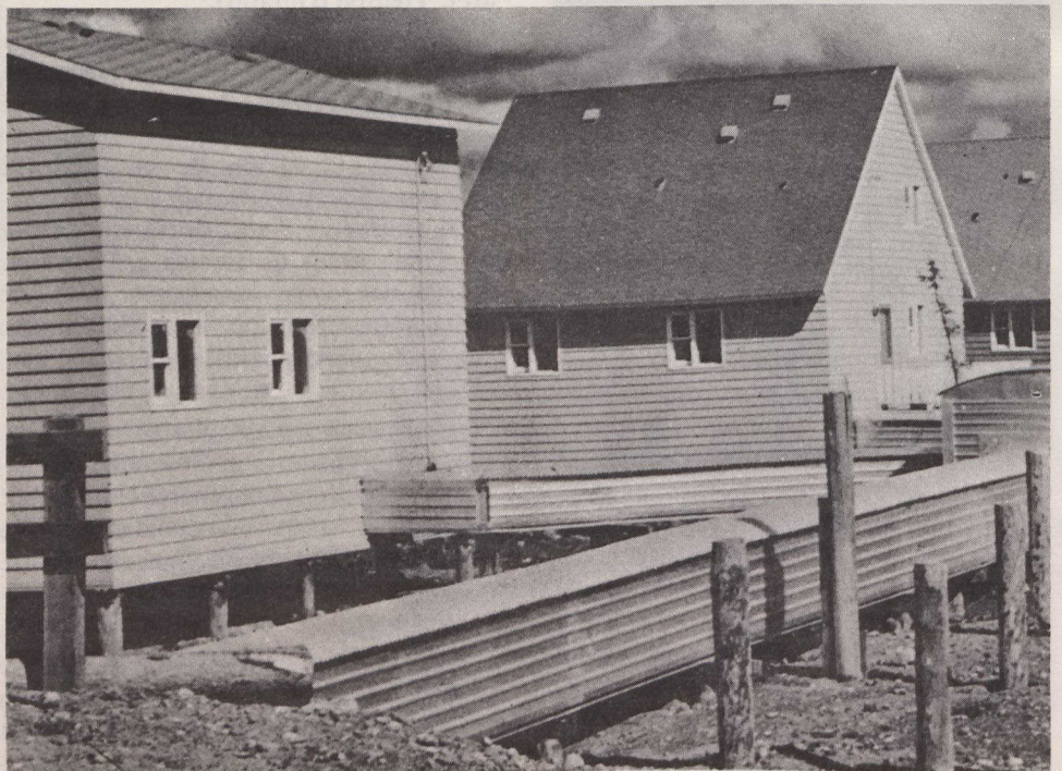
Les réseaux d'égouts et d'adduction sont installés sur le sol ou sur des pilotis, dans des enceintes isolées appelées “utilidors” et que l'on peut voir ici à Inuvik, T.N.-O.
