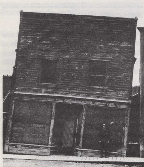
Le dégel du pergélisol sous-jacent est responsable de l'affaissement inégal, de l'inclinaison et du gauchissement de bâtiments comme ce magasin du centre de Dawson, dans le Territoire du Yukon.
