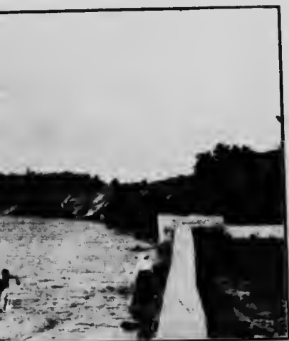
er above Holmedale Dam. Page 20.
