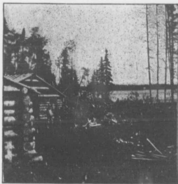
CHANTIER DU LAC PLANTIN
