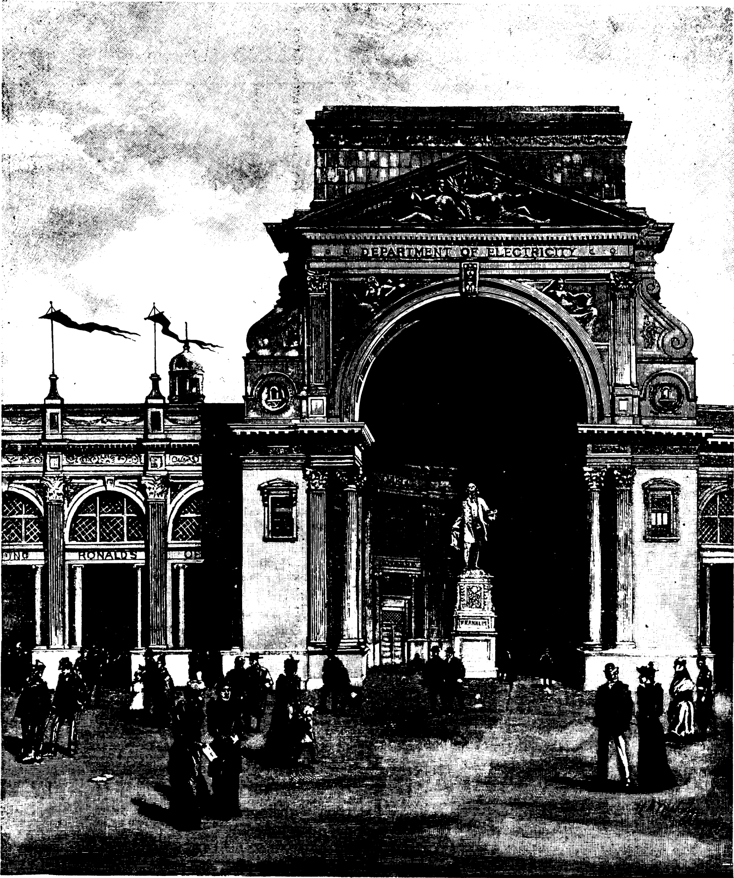
L'EXPOSITION COLOMBIENNE — ENTRÉE A LA BATISSE DE L'ÉLECTRICITÉ, COTÉSUD
