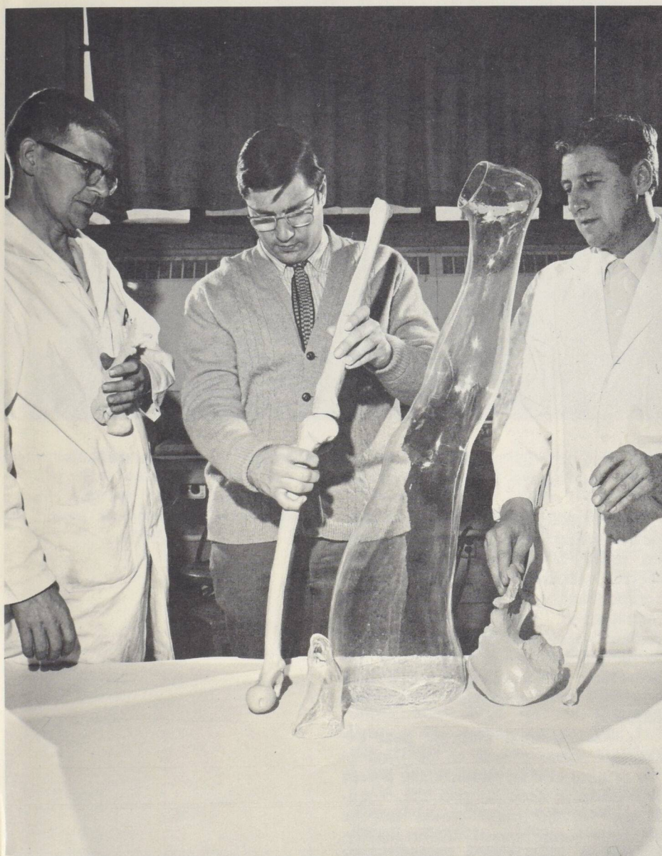
En présence de Gerry Beaudry (à gauche) et William Ward, de la Division de Mécanique (section maquettes) qui a fabriqué le membre artificiel, le Dr Morris Milner assemble des os artificiels avant de les placer dans une maquette grandeur réelle de sa propre jambe.
