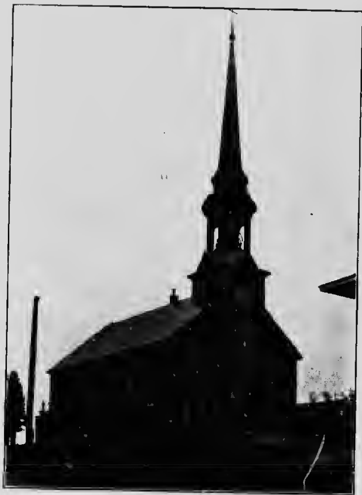
ÉGLISE DE SAINTE-FOY bâtie en 1876-1878, Avant la pose des statues du S. Cœur et de S. Michel aux angles du toit de la façade, en septembre, 1908.
