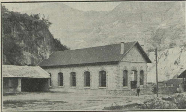
Power Station, Zwolfmalgreien.
