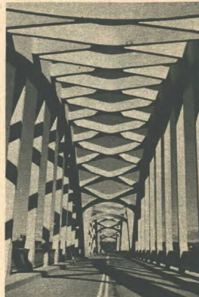
4) Pont en ciment sur une rivière de la Saskatchewan
