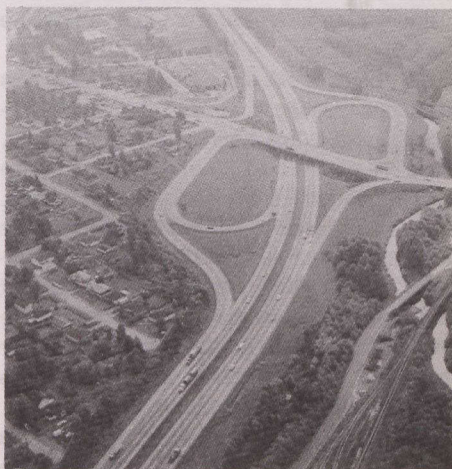
Un des neuf échangeurs en béton précontraint de la route transcanadienne en Colombie-Britannique.
