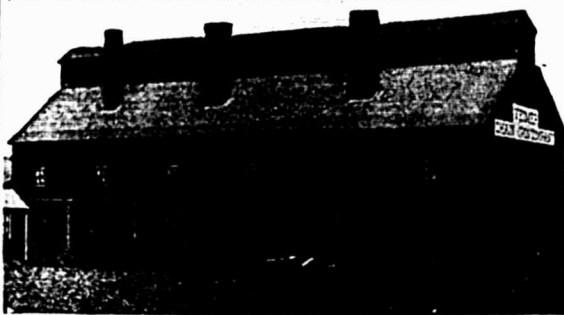
Bâtisse de la Welmer Chain & Iron Co. Pa., couverte avec Amatite
