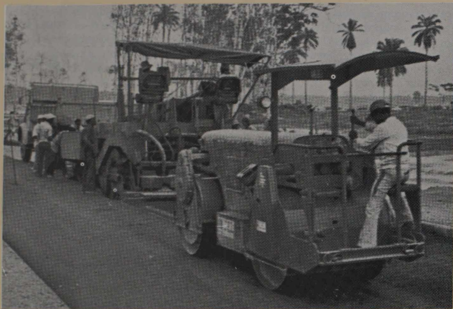
● Asphaltage de route au Nigéria
