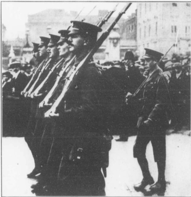
LE PRINCE DE GALLES EN ROUTE POUR LE FRONT.
