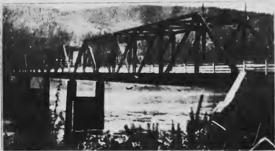
FIG. 10.—Le pont public de la rivière Columbia, près de Trail, C.-B., en 1912-13.
