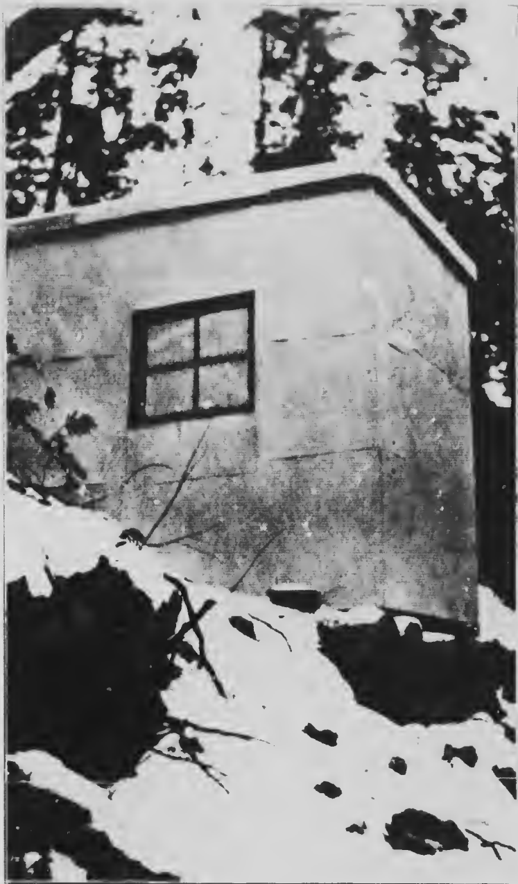
Rivière Adams - Abri de la jauge automatique.
