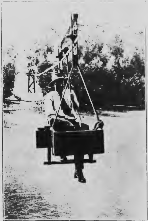
District de Cranbrook (III) — Photographie indiquant la ligne du câble et la manière de s'en servir.
