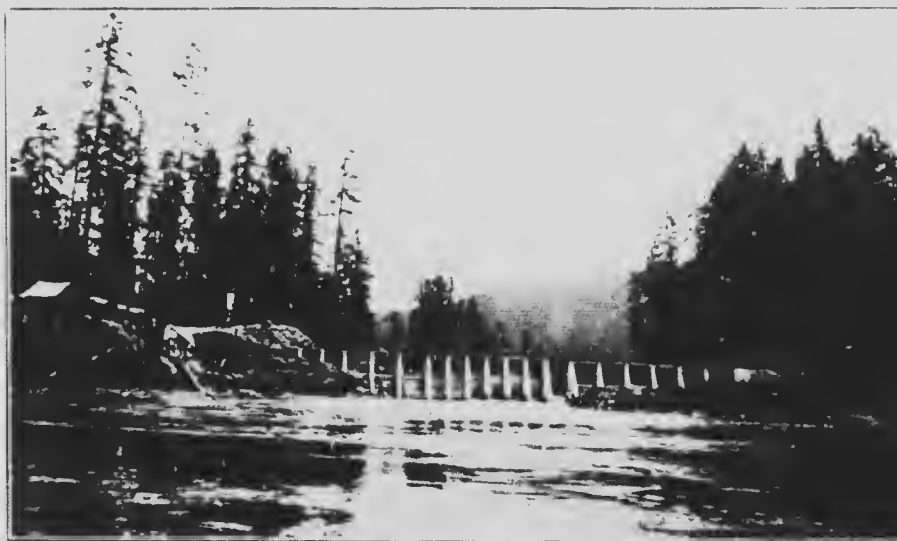
Barrage du réservoir de l'Usine Hydro-Électrique de la rivière Puntledge sur la rivière Puntledge, près de la décharge du lac Comox.
