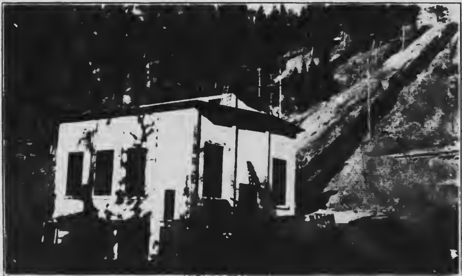
L'extérieur de l'usine d'énergie hydro-électrique Barrière. — Installation municipale de la ville de Kamloops, Colombie-Britannique.
