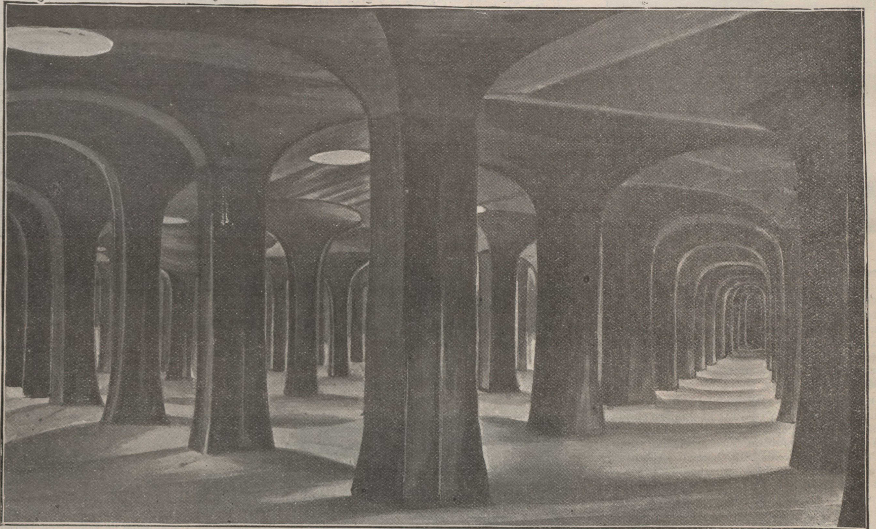
Intérieur du bassin de filtration adapté à l'aqueduc de Washington
